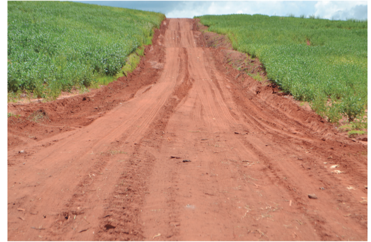
Com a retirada do lixão a estrada rural que liga a pedreira está sendo recuperada
