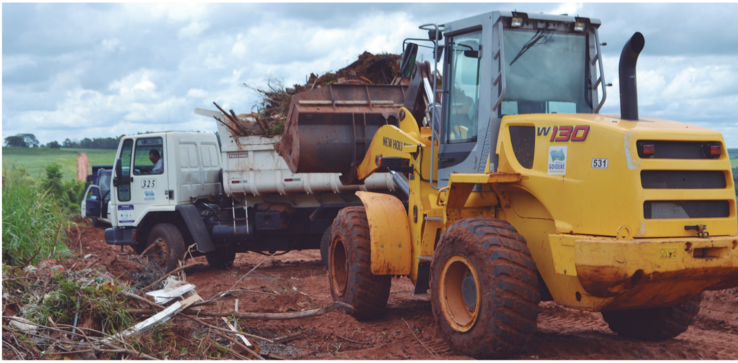
Máquinas e caminhões da Prefeitura estão mobilizados no trabalho de limpeza da estrada rural abaixo do Jardim Tropical
