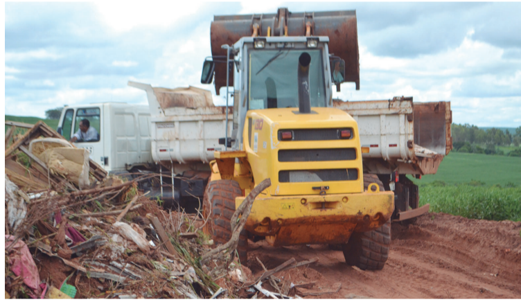
Intenso trabalho está sendo desenvolvido na limpeza do local
