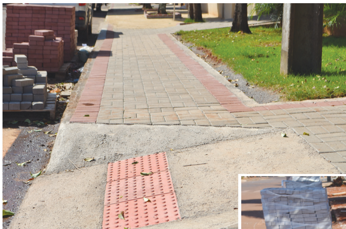
A padronização da calçada com paver proporciona um novo aspecto visual
