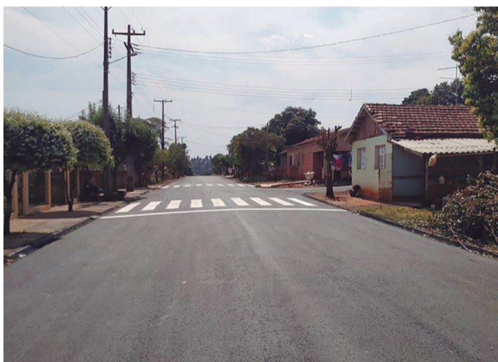
O recapeamento asfáltico atendeu a região central de Bredapólis
