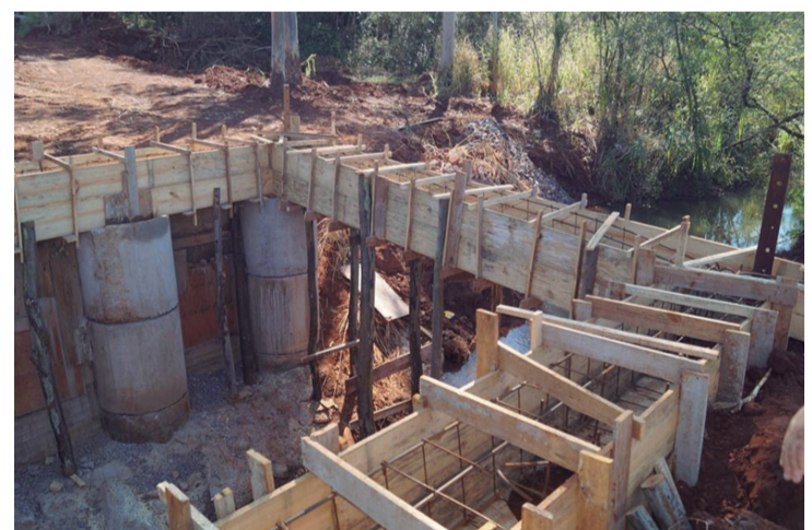
A ponte do Takao foi construída em concreto armado
