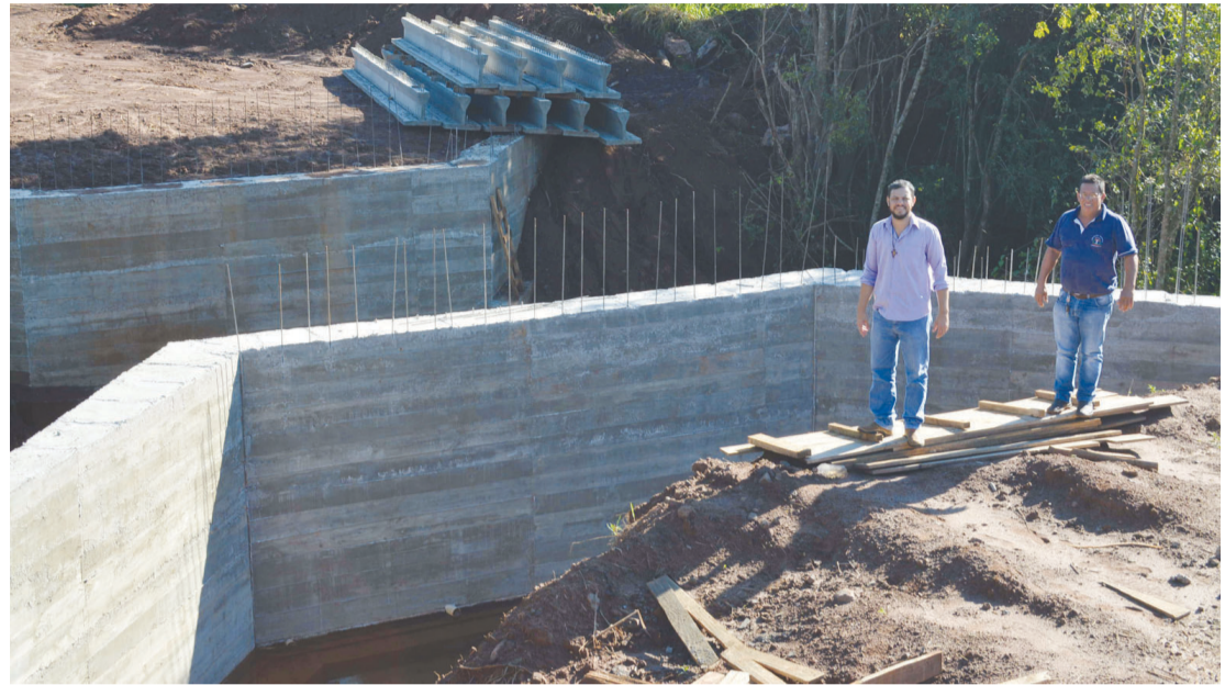
Diversas pontes em concreto foram construídas no período de interinidade de Tiago Albano
