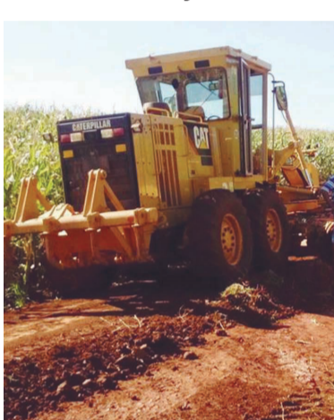
Toda a malha viária recebeu melhorias
