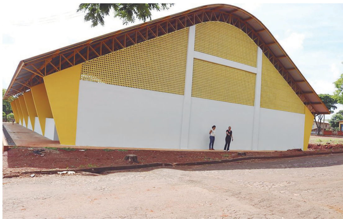
O Ginásio de Esportes será concluído nos próximos dias
