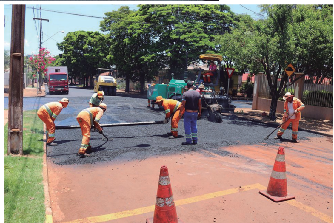
Toda a área central será recapeada com serviço de primeira qualidade
