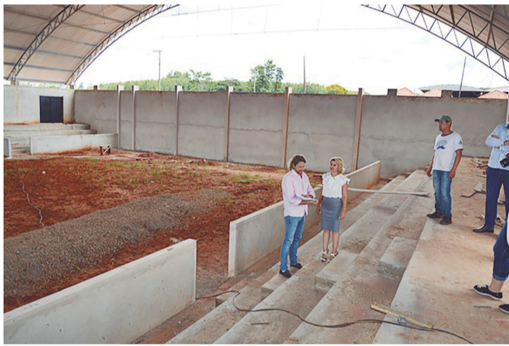
O Ginásio de Esportes está em fase de construção
